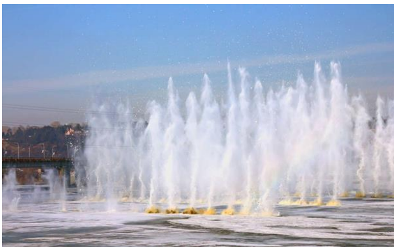
Рис. 3.20. Підривання заторів льоду
